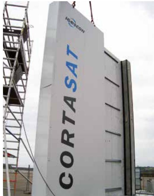
Ensayos de montaje y desmontaje solución modular muro cortafuegos.
