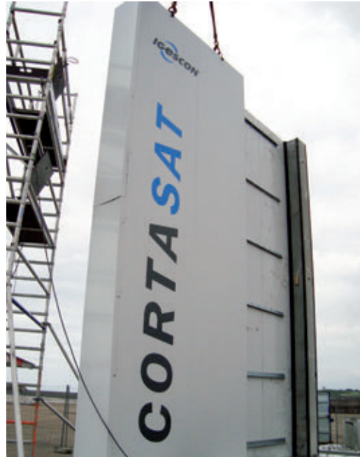
Ensayos de montaje y desmontaje solución modular muro cortafuegos. New firewall constructive solution.
