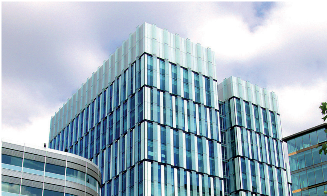
Oficinas de BABCOCK Montajes en Manchester, UK. BABCOCK Montajes offices in Manchester, UK.
