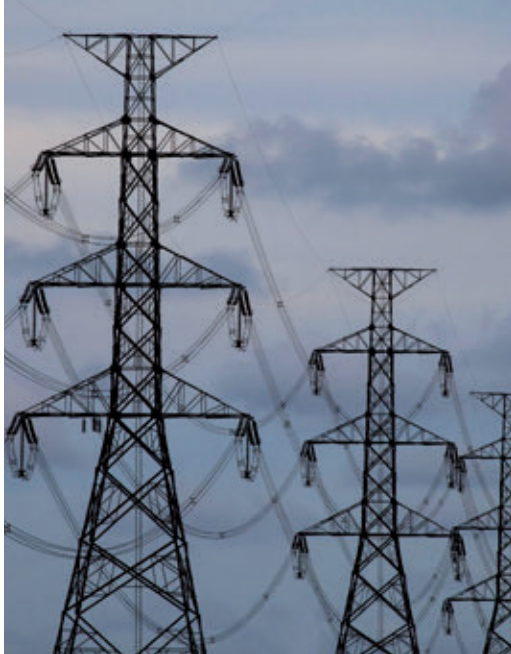
Líneas eléctricas. Power lines.
